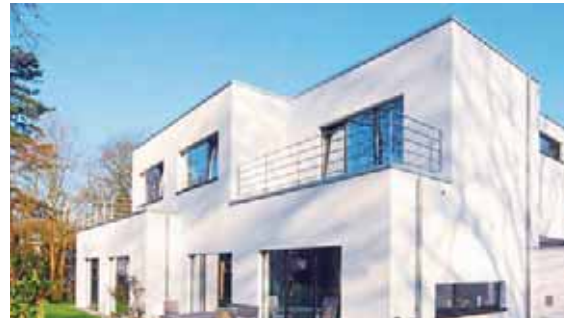
OBJEKT ME NJË SHTRESË IZOLIMI NDËRTIMI I VRAZHDË ËSHTË KRYER ME XELLA - SILKA
